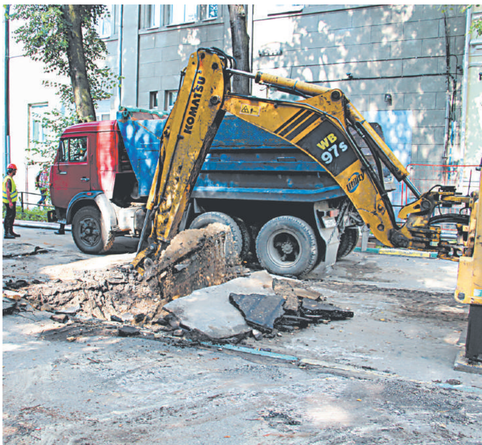
Работы по замене теплотрассы отопления проводятся с использованием современных стальных трубопроводов в пенополимерминеральной изоляции (ППМ).
