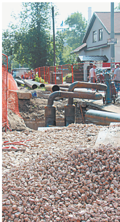
Второй пункт посещения: работа по замене участка теплотрасс на пересечении улиц Кулибина и Пушкина.
