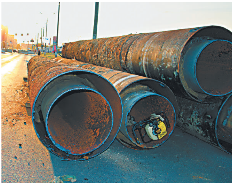
Замена теплотрассы на пересечении Мещерского бульвара и ул. Бетанкура.
