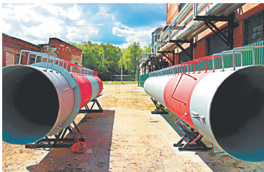
Замена дымовой трубы на котельной по ул. Гагарина, 70.
