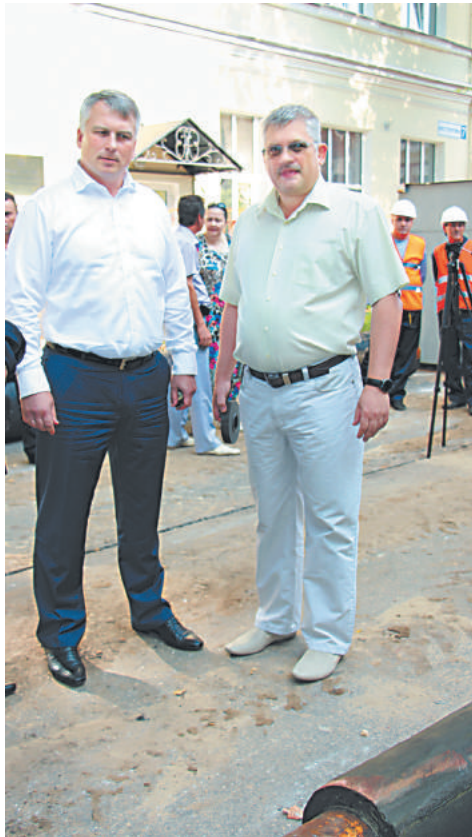
Глава администрации Нижнего Новгорода Сергей Белов и генеральный директор ОАО «Теплоэнерго» Александр Котельников инспектируют первый участок на пересечении улиц Нестерова и Большой Печерской.
