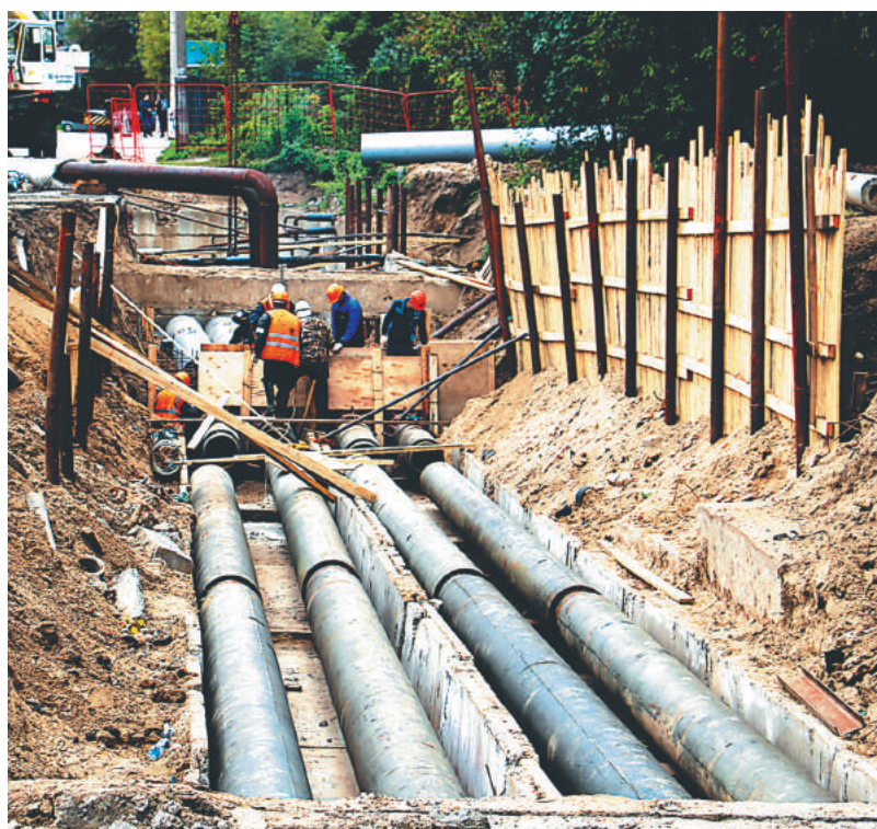
Ремонт теплотрасс на ул. Академика Баха.
